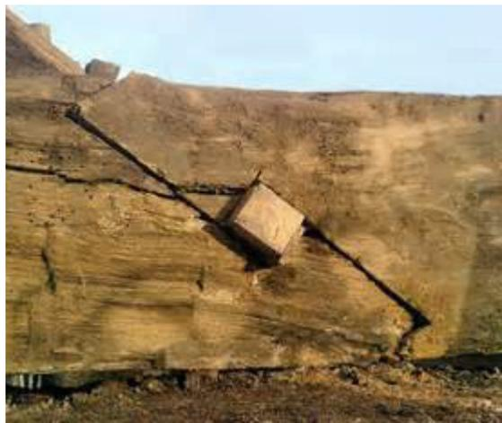
2. Méthode d'assemblage de poutres en bois utilisée par les charpentiers, résistante à la compression et à la traction.
